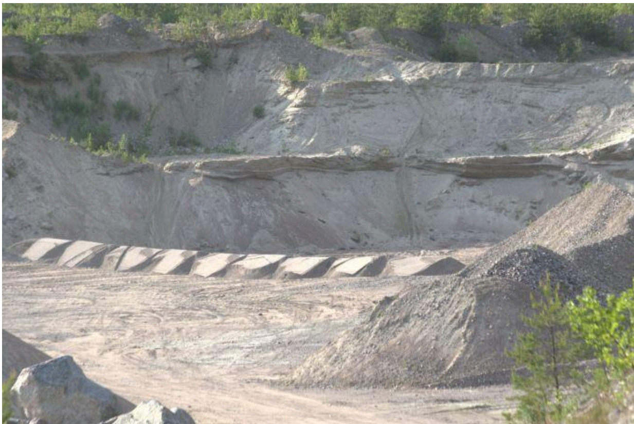
Yläkuvassa Sorhei Oyn rakentama Hälvälänkankaan törmien suojavalli 6.6.2025.
