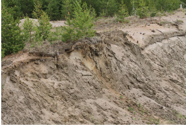
Vasemmalla kuva vanhalta E-montulta 9.5.2022. Seinämät ovat valuneet veden ja tuulen vaikutuksesta huonoon kuntoon.
