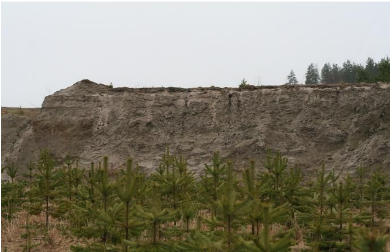
Vanhan E-montun NW-törmän lähtötilanne ennen kunnostusta.
